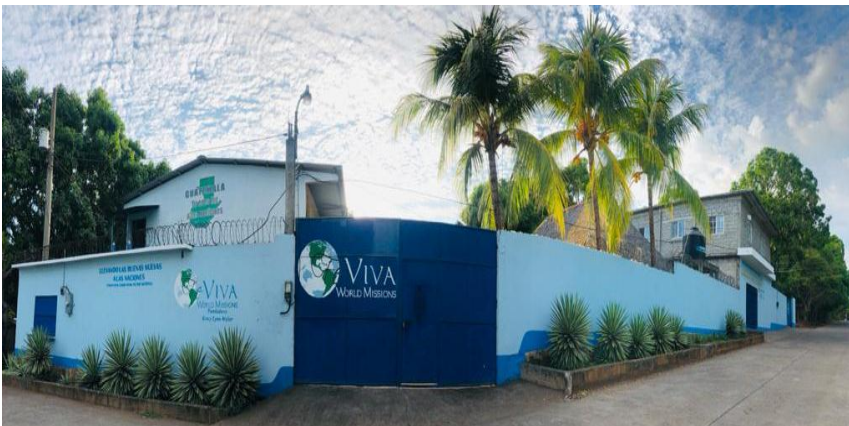
Figura 9. Entrada al lado oeste de la institución, donde se prestan los siguientes del Colegio particular mixto cristiano Fe Viva, Instituto bíblico Fe Viva y residencial
