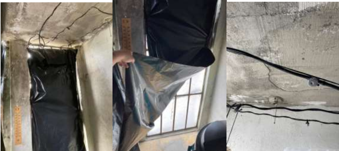
Figura 33. Sala de producción artesanal y sistema de riego por microaspersión
