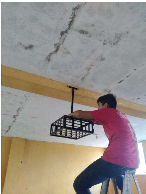
Figura 14 Instalación de soportes para videoproyectores
