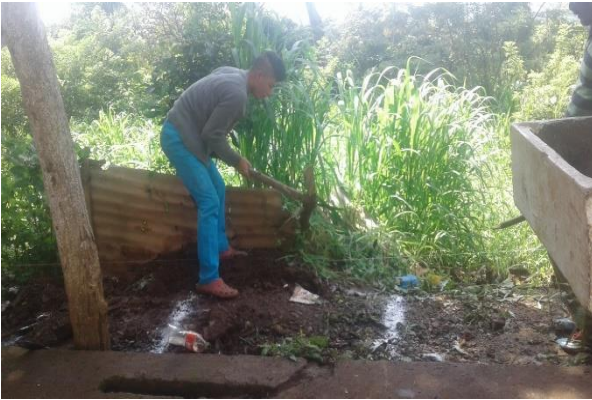
Durante Figura No.8. Zanjeo
