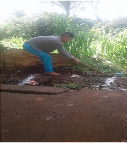
Figura No.7. Limpieza
