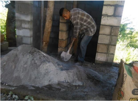
Figura No.10. Preparación de material.
