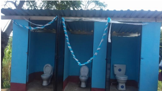
Figura No.14. Interior del módulo
