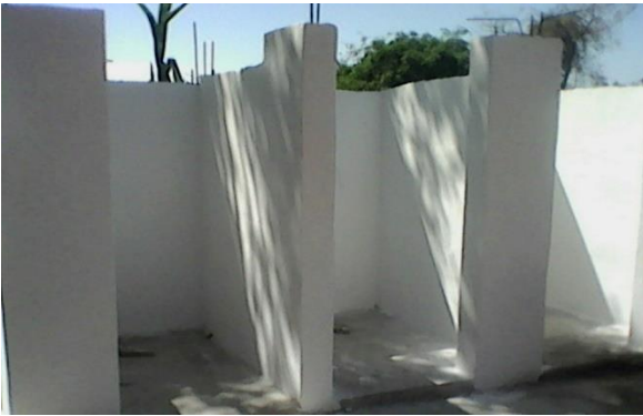
Figura No.11. Acabado de pared.
