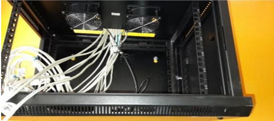
**Nota:** forma de cómo se realiza el ensamblaje del cableado, ya sea de forma trenzada protegido o lineal, esto para el servicio del internet en diferentes partes del edificio. Las fotografías fueron tomadas durante el proceso de la instalación.
