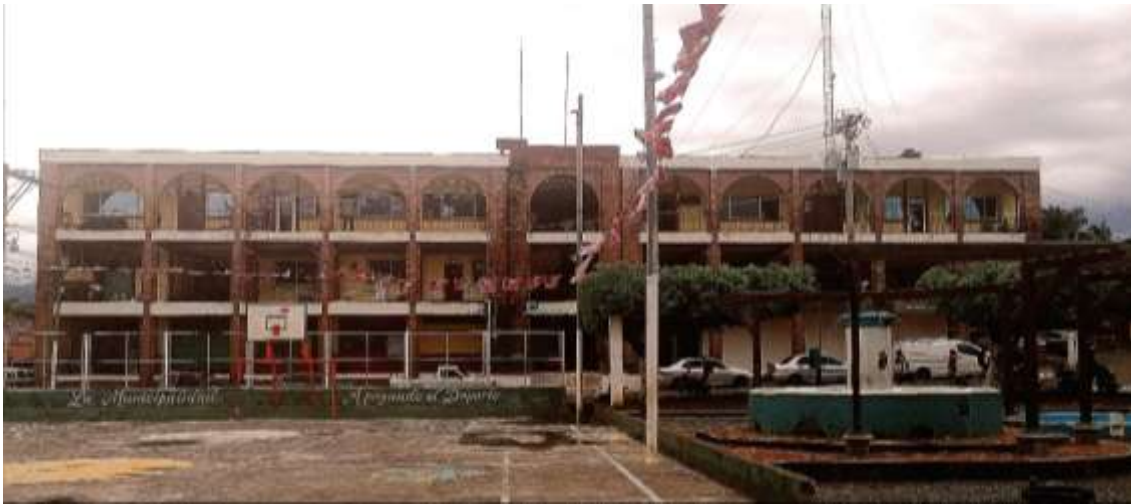
Figura 3 Actual edificio municipal 2021
