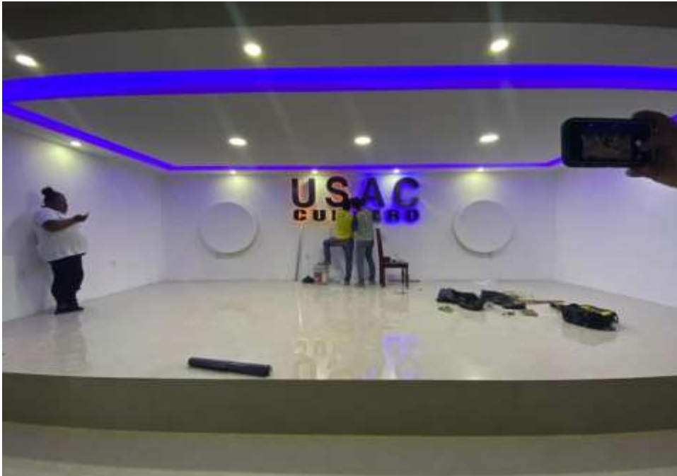
figura 18 Instalación de rótulos luminosos
