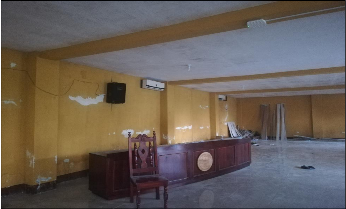
Fotografía 7 Instalaciones del salón de usos múltiples de CUNSARO Chiquimulilla
