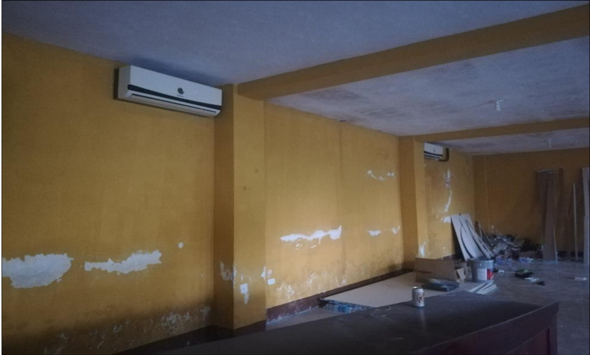
Fotografía 9 Instalaciones del salón de usos múltiples de CUNSARO Chiquimulilla.
