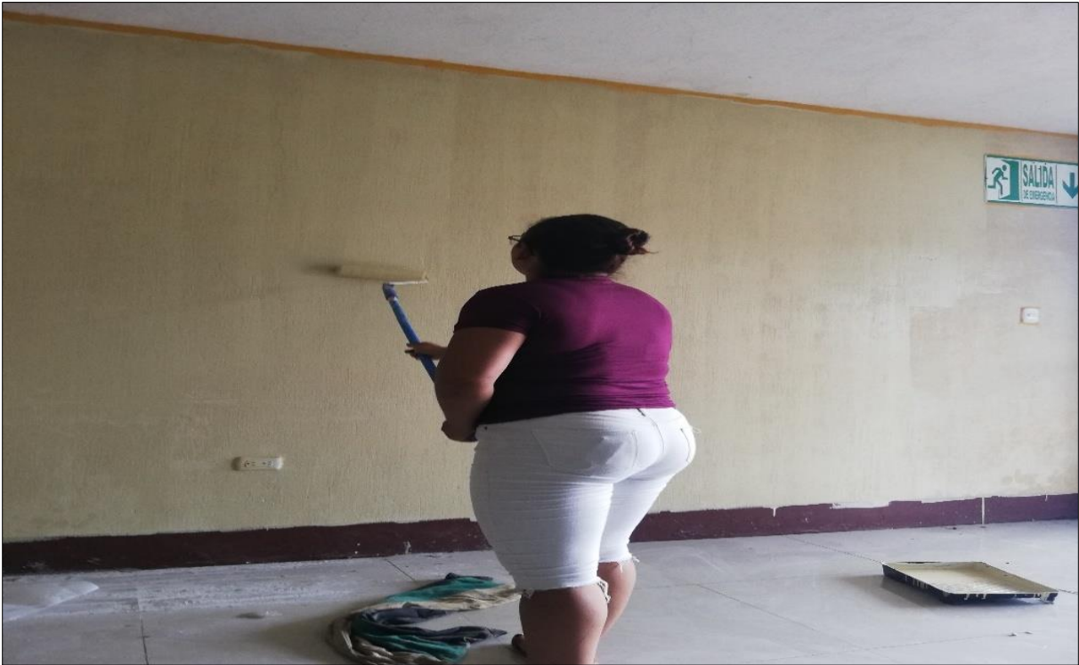
Fotografía 13 Revestimiento de pintura del salón de usos múltiples de CUNSARO Chiquimulilla.
