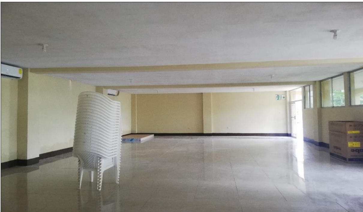
Fotografía 16 Proyecto terminado de voluntariado, revestimiento del salón de usos múltiples de CUNSARO Chiquimulilla.
