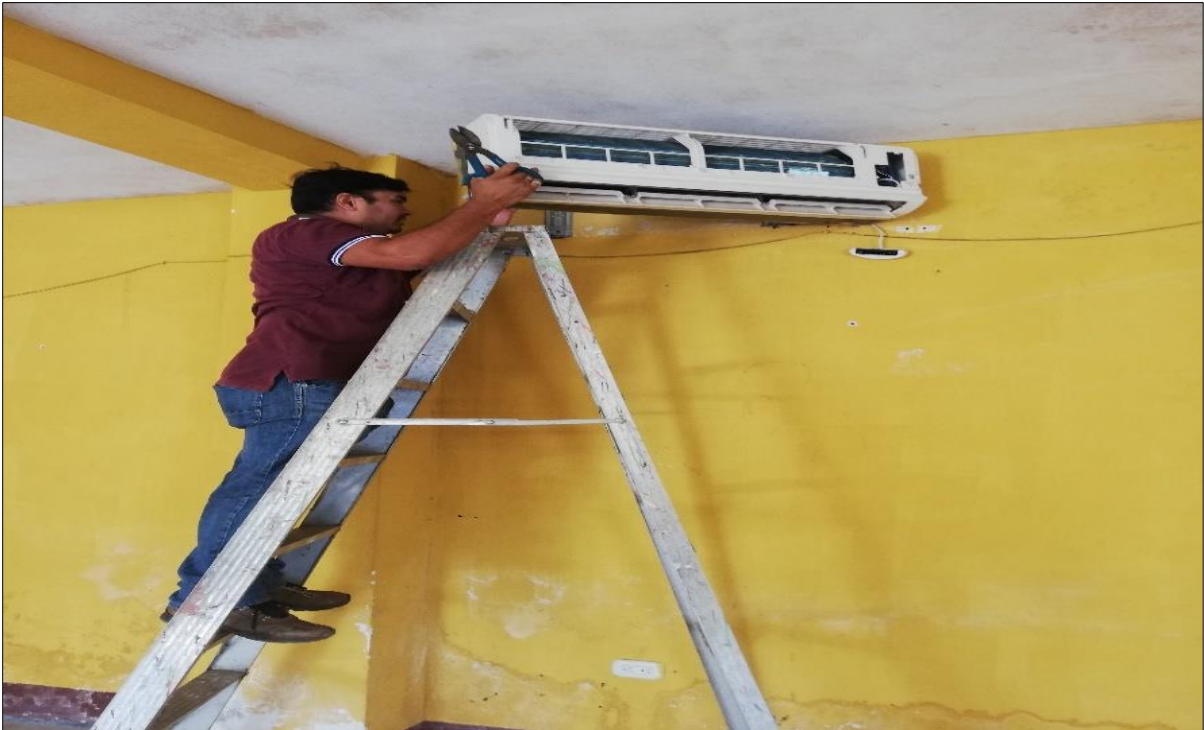
Fotografía 11 Desinstalación de aires acondicionado en mal estado del salón de usos múltiples de CUNSARO Chiquimulilla.
