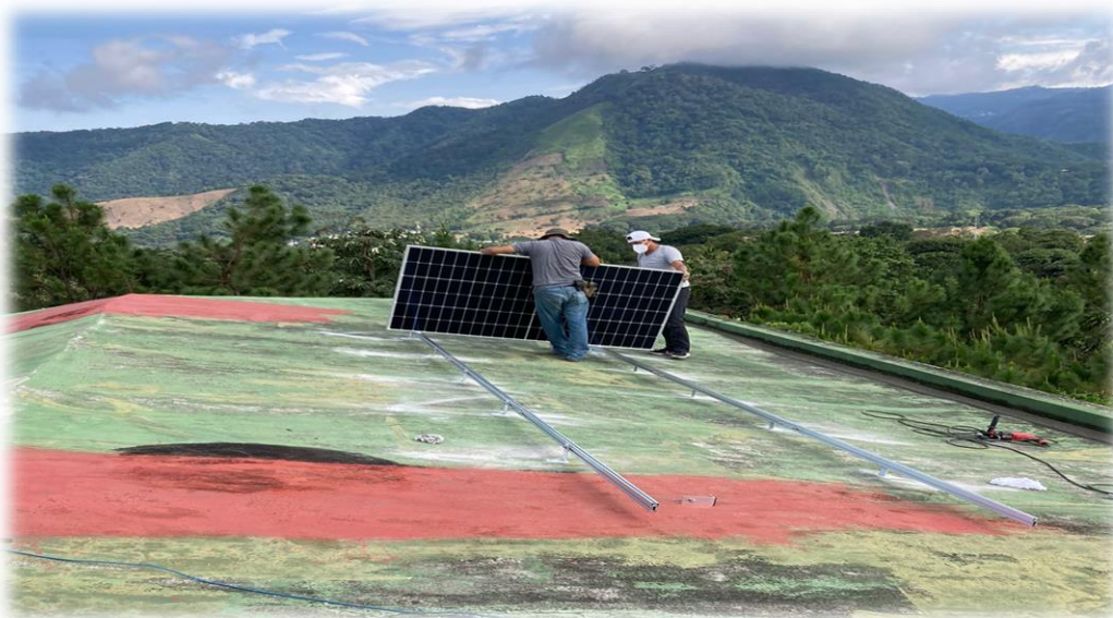
Fotografía No. 19. Durante la instalación de paneles solares del el proyecto de voluntariado /Fuente: Saira Sucely Hernández Ramirez Estudiante ejecutor
