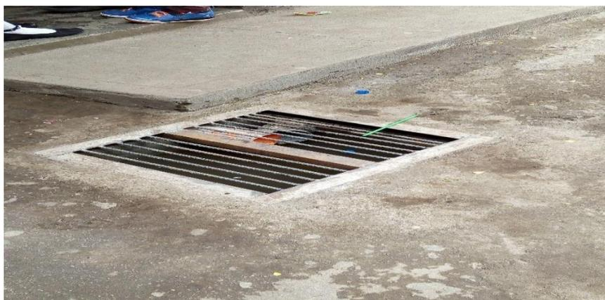
Figura 21. Rejilla para captar el agua de lluvia
