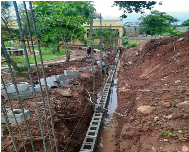
Figura 29 Colocacion de Blocks para la construcción del muro de contención
