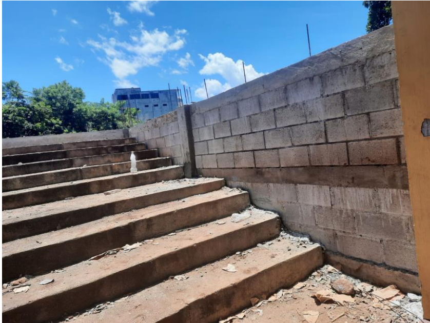
Figura 13 Finalización del muro de contención parte
