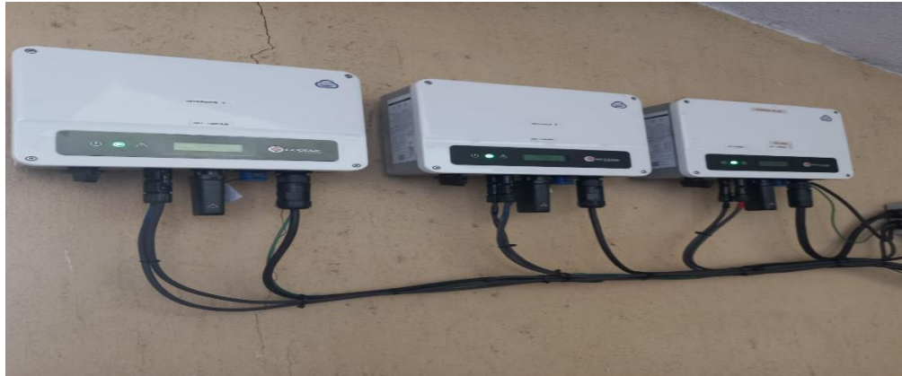
Fotografía No. 63 Instalación de filpones
