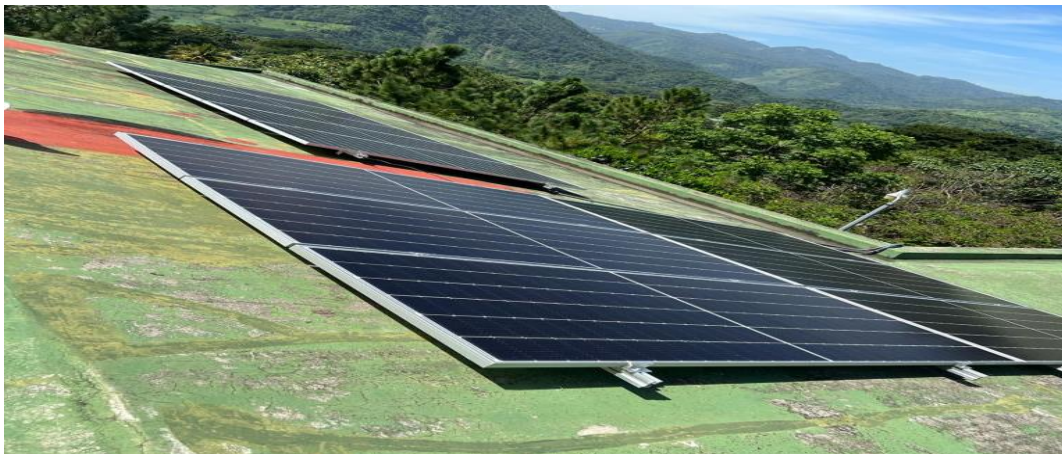
Fotografía No. 64/ Instalación de la panel solar lista para el uso del Centro del Centro Universitario.
