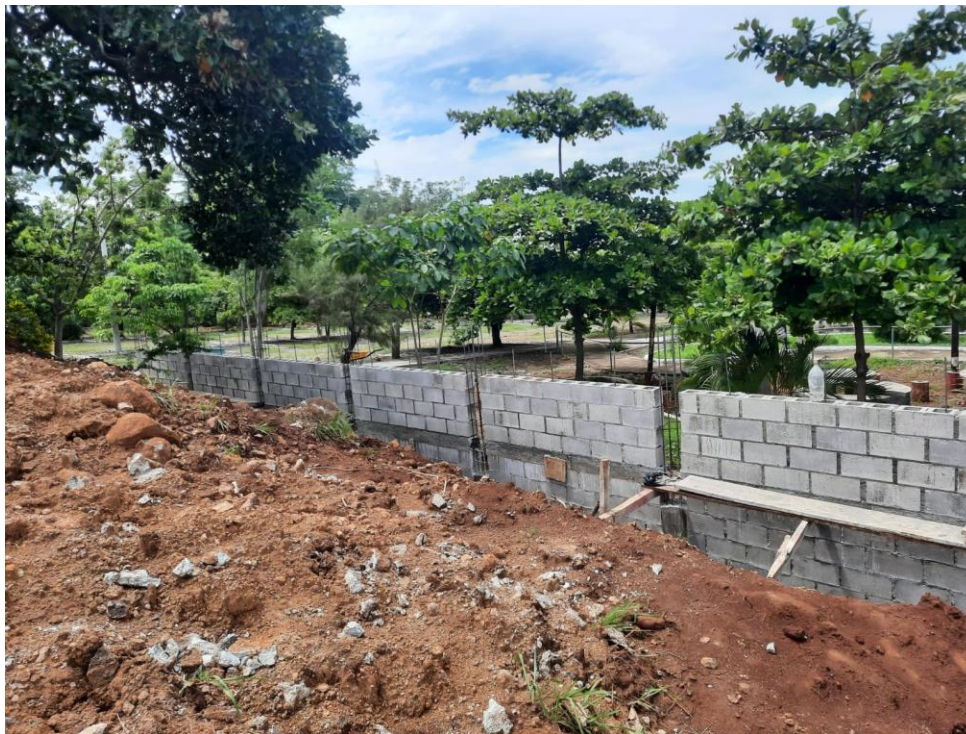
Figura 33. Construcción del muro de contención.
