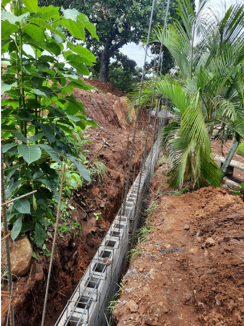
Figura 32. Colocación de Block para la construcción del muro de contención.
