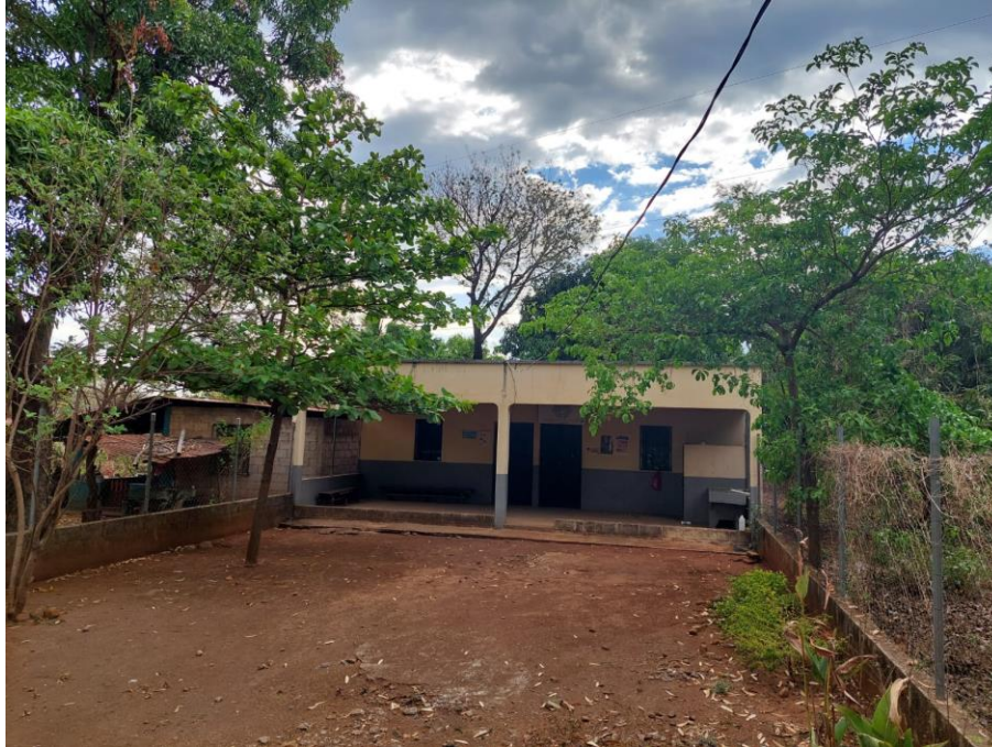
Figura 8. Sede del Órgano de Coordinación “Instalaciones del Centro de Salud” antes de la intervención.
