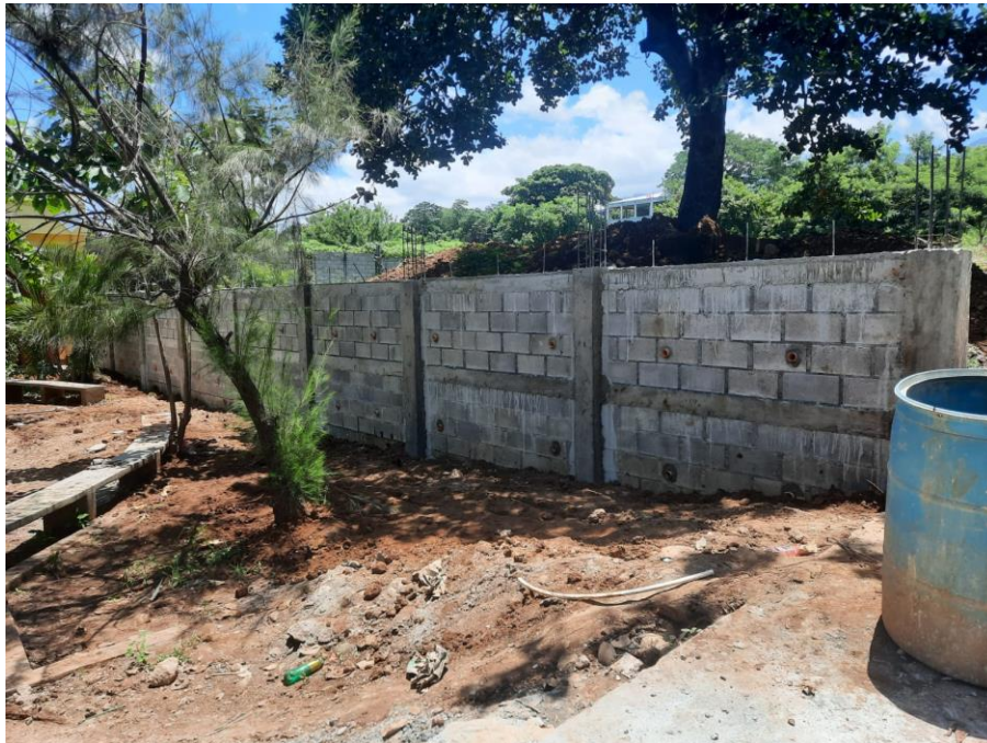
Figura 36. Finalización del muro de contención parte 2.
