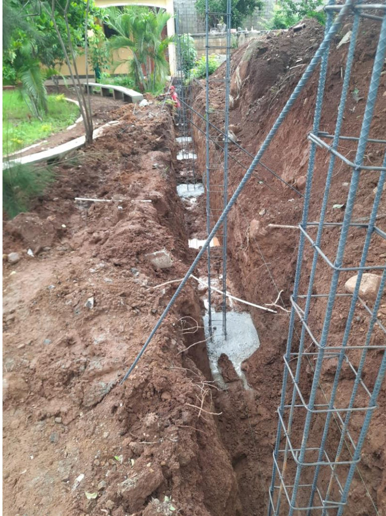
Figura 30. Inicio de colocación de columnas para el muro de contención.
