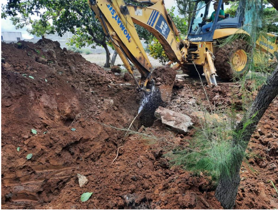
Figura 28. Abertura de zanja para construcción del muro de contención.
