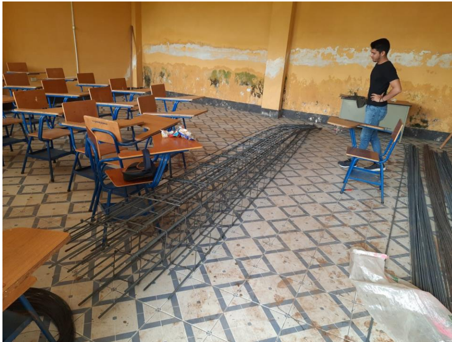
Figura 29. Preparación de columnas para construcción del muro de contención.
