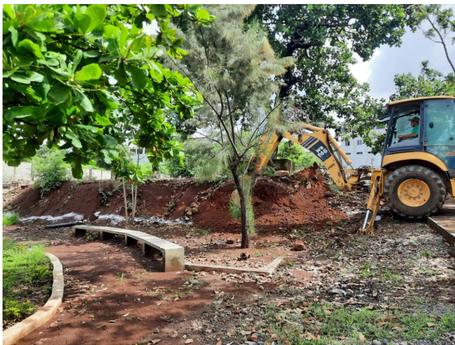
Figura 27. Inicio de construcción del muro de contención.
