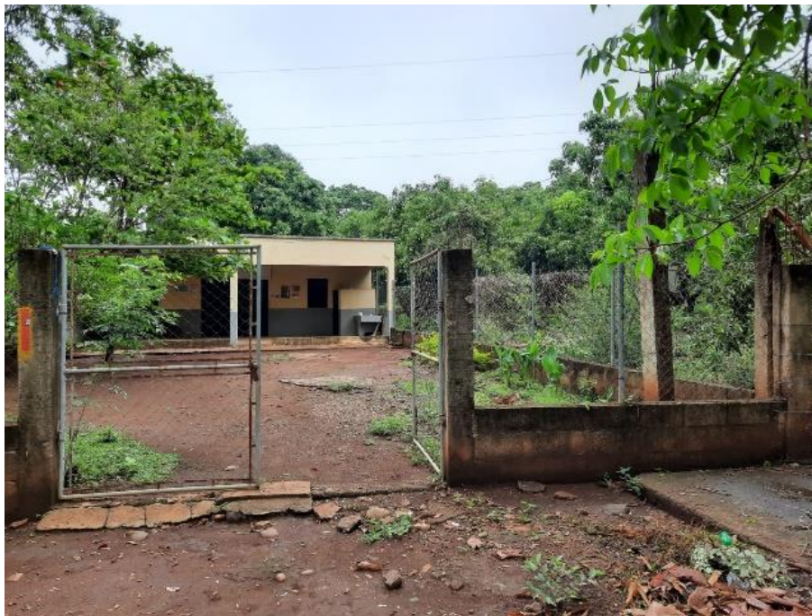
Figura 10. Ingreso de la sede del Órgano de Coordinación “Instalaciones del Centro de Salud” antes de la intervención.
