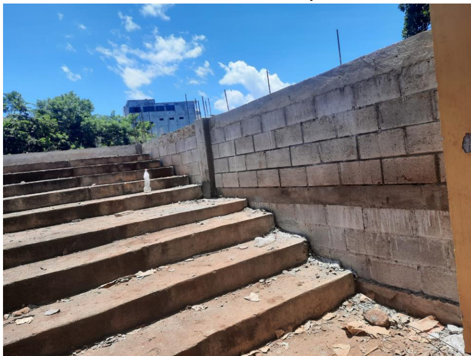
Figura 37. Finalización del muro de contención parte 3.
