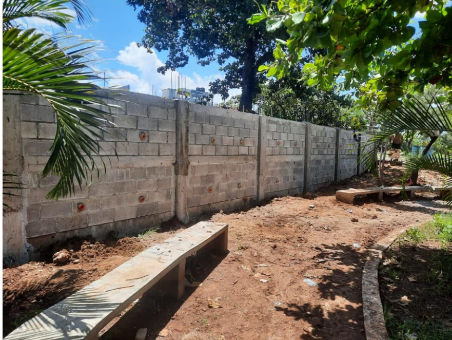
Figura 35. Finalización de la construcción del muro de contención parte 1.
