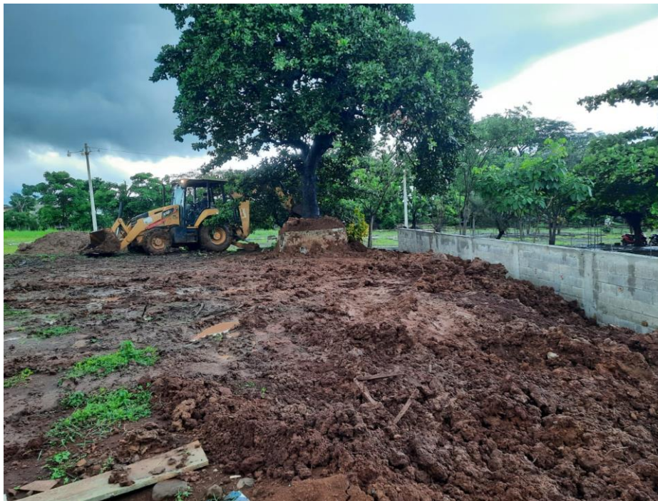
Figura 34. Nivelación de tierra para el muro de contención.
