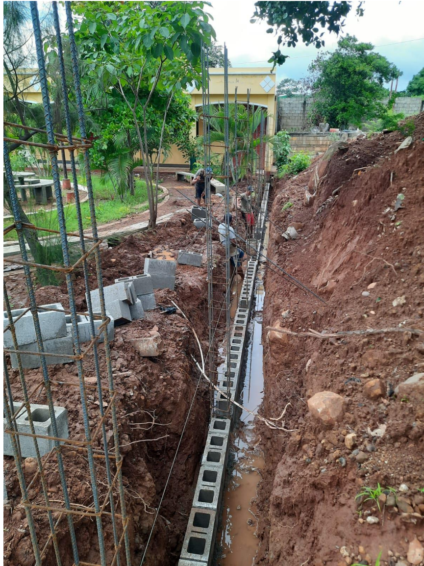
Figura 31. Colocación de Blocks para la construcción del muro de contención.
