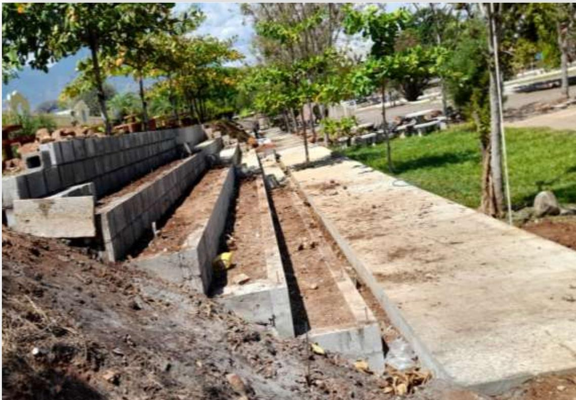
Nota. Las figuras muestran la construcción de zanjas y pegado de block.
