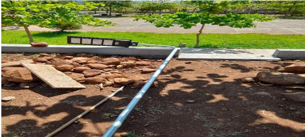
Nota: antes de la fundición del tubo en el área seleccionada se procede a colocar la lámpara solar en el soporte previamente preparado para su instalación.
