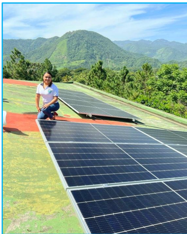
Fotografía No. 30. Estudiante ejecutor verificando los paneles solares instalados.
