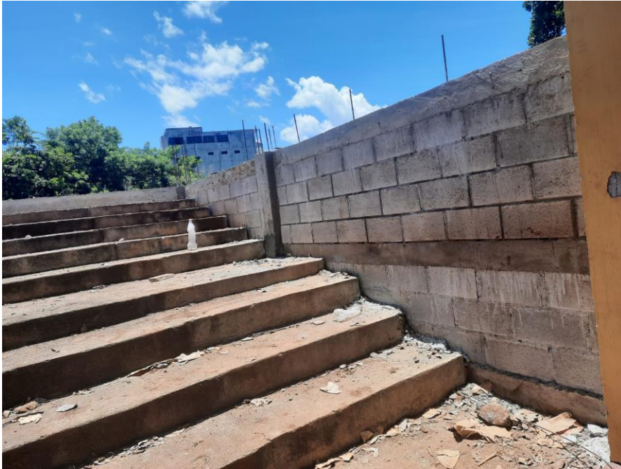
Figura 17 Muro de contención parte 2
