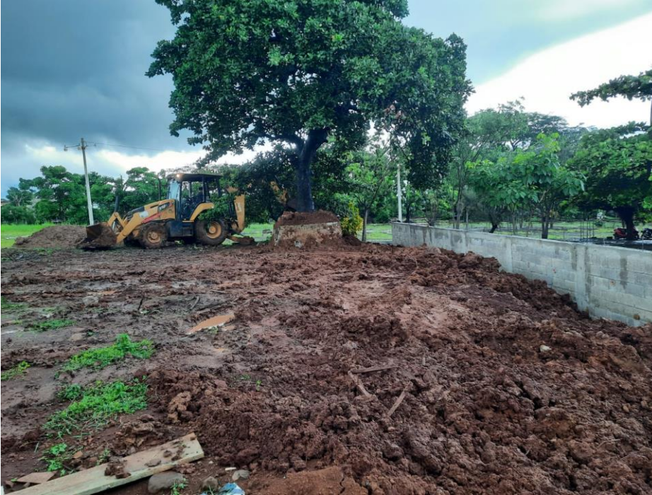
Figura 15 Nivelación de tierra
