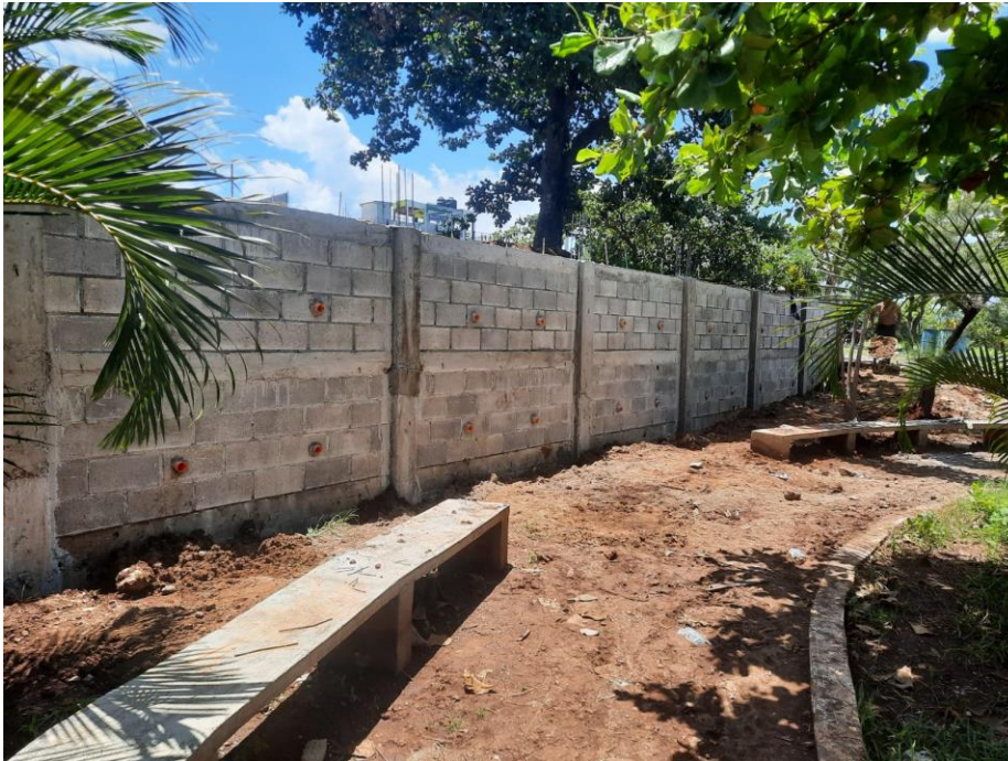
Figura 16 Finalización de muro de contención
