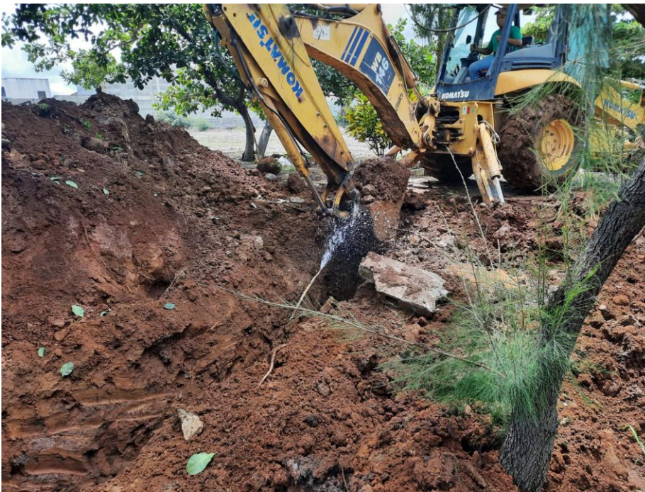
Figura 12 Excavación para cimientos
