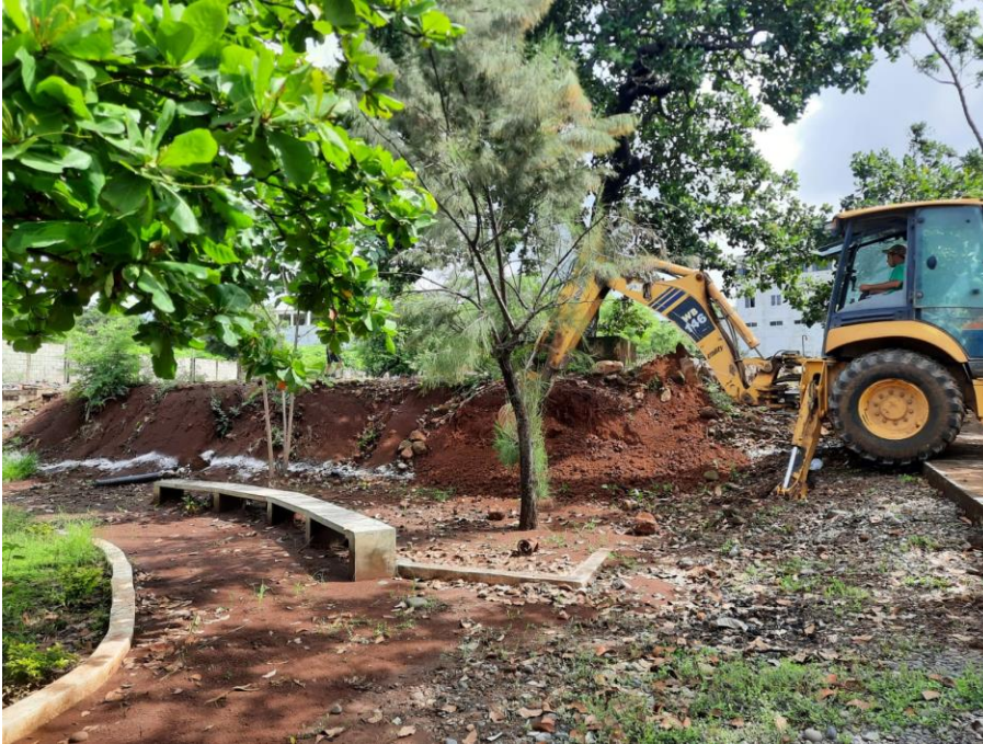
Figura 11 Inicio de zanjeo muro de contención
