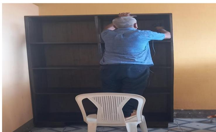
Nota. Se atornilló la madera para asegurarla en la pared para evitar el riesgo a caída.
