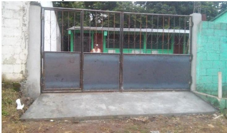
Nota: se instaló el portón quedando soldado en las columnas de hierro y fundido en las bases de concreto.
