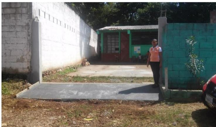
Nota: Se realizaron las bases de cemento y una plancha para garantizar la durabilidad del portón.
