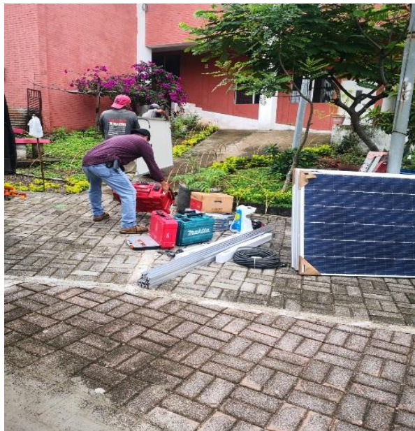
Fotografía No. 17 Trasladando los materiales.
