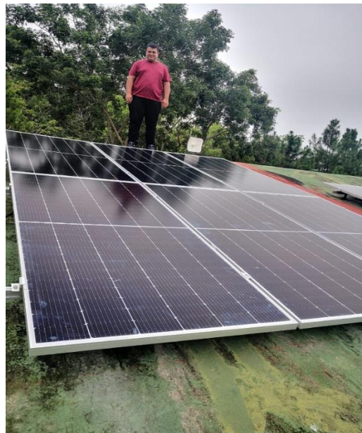
Fotografía No. 28 Después de la instalación de los paneles solares.
