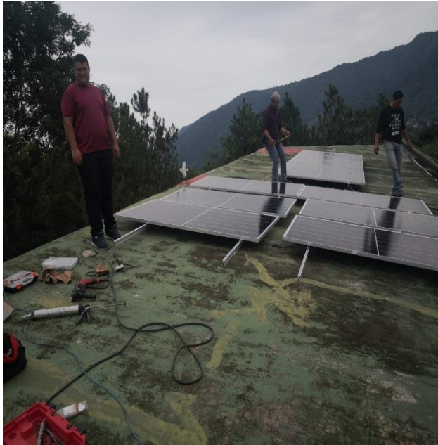
Fotografía No. 25 Durante la ejecución del proyecto.
