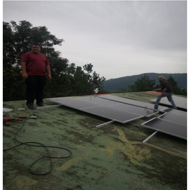
Fotografía No. 26 Durante la ejecución del Proyecto.
