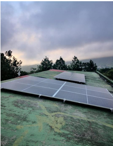
Fotografía No. 27 Después de la instalación de paneles solares.
