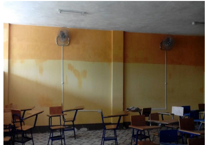
Nota: culminación de con la pintura en paredes
