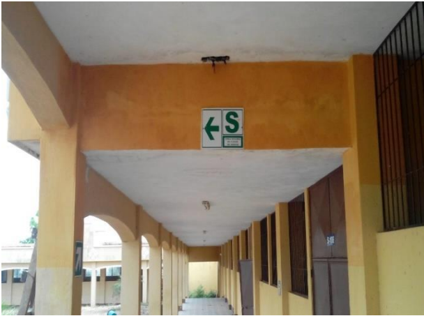
Nota: finalización con la pintura en columna 1
