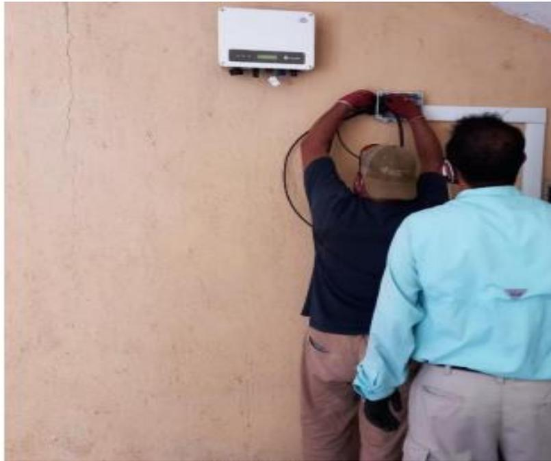
**Fotografía 25.** Conexión de cables para instalación de distancia de inversor: 18 metros de Paneles Solares. **Fuente/**Estudiante del Ejercicio Profesional Supervisado.
