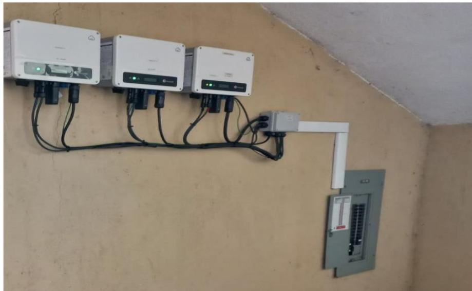
**Fotografía 26.** Instalación de distancia de inversor: 18 metros de Paneles Solares. **Fuente/**Estudiante del Ejercicio Profesional Supervisado.
