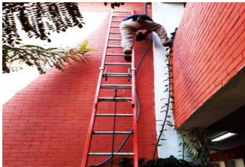
**Fotografía 24.** Medición a la instalación de distancia de inversor: 18 metros de Paneles Solares. **Fuente/**Estudiante del Ejercicio Profesional Supervisado.
