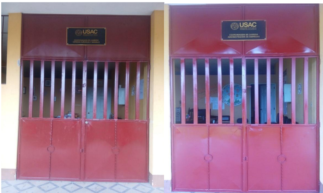
Figura 9 Estructura metálica finalizada de los portones
