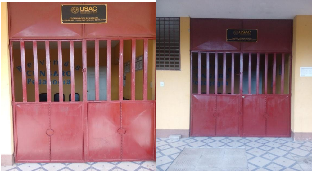
Figura 8 Portones terminados instalados
