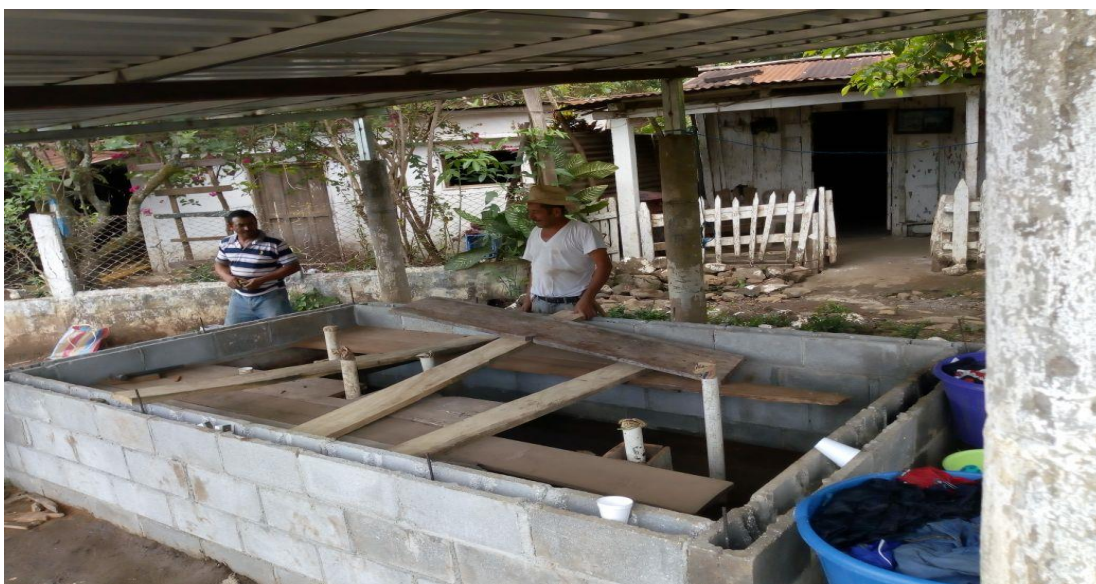
Figura 9. Avance del mejoramiento de la pila. (durante)
