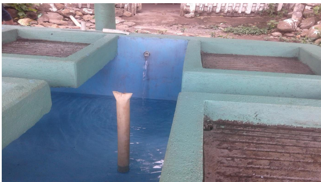
Figura 13. Se observa el inicio del llenado de la pila. (después)
