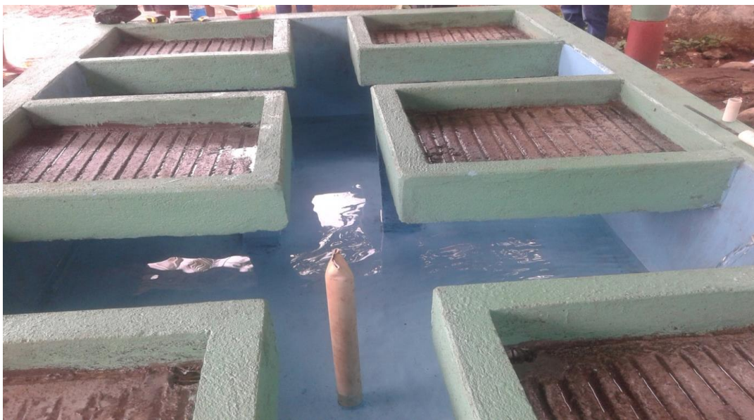
Figura 14. Se puede apreciar en la imagen el Proyecto finalizado. (después)
