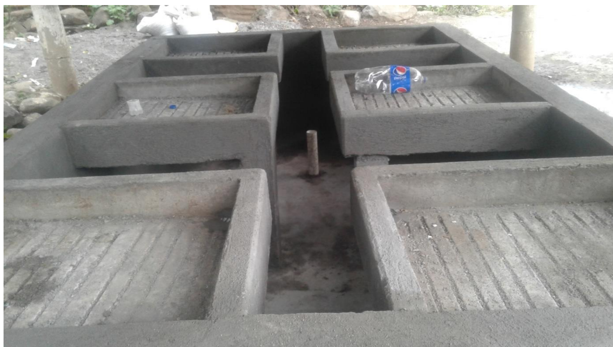
Figura 11. Vista de los seis lavaderos fundidos y terminados. (durante)
