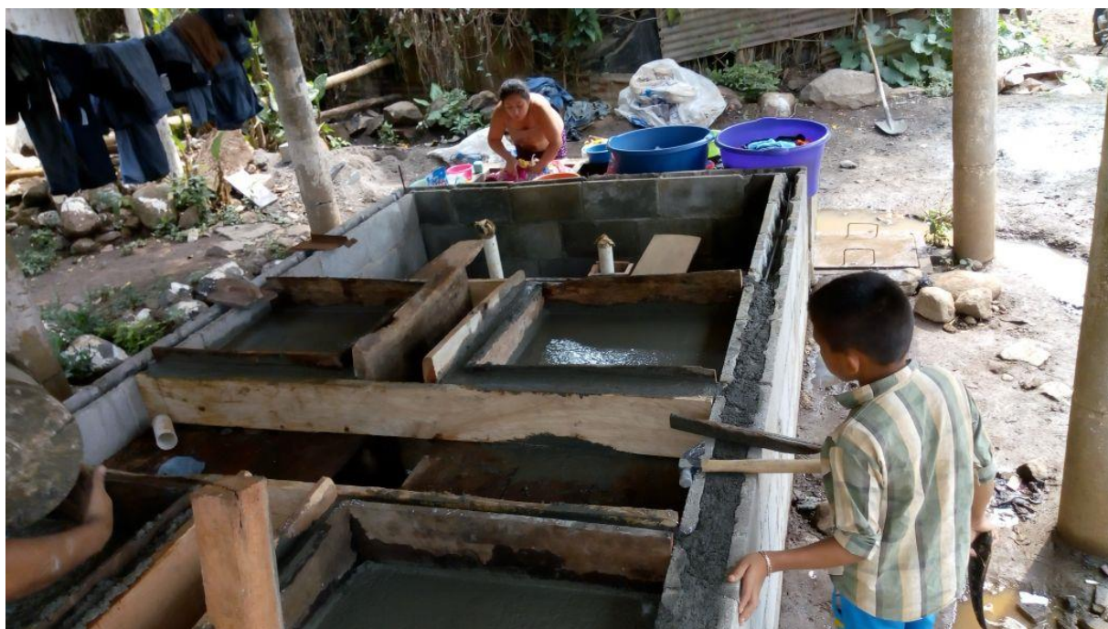
Figura 10. Fundición de lavaderos. (durante)
