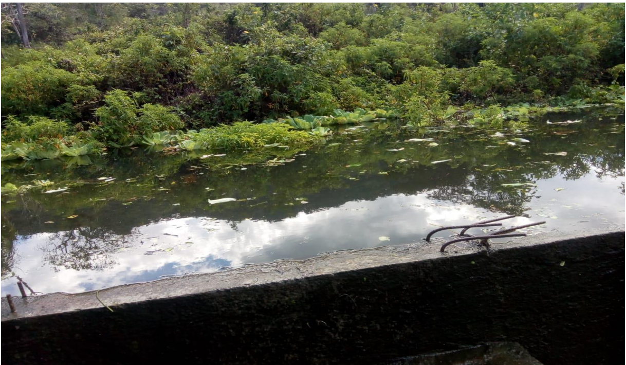
Figura 21. Vista panorámica de cómo quedó el afluente de agua al finalizar la jornada de limpieza.
