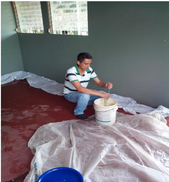
Figura 4. Epesista preparando pintura para las paredes del salón.
