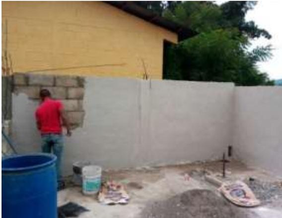
Figura 7. Terminación del repello del área. Fotografía por: Silvia de León
