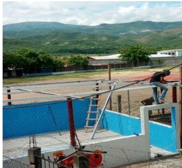
Figura 14. Colocación de costaneras. Fotografía por: Silvia de León
