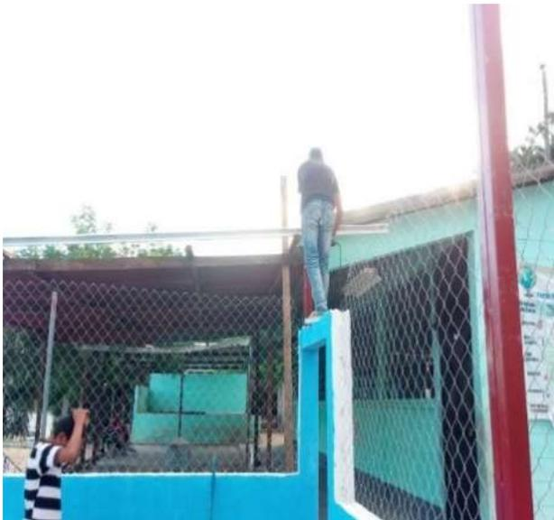
Figura 13. Colocación de costaneras. Fotografía por: Silvia de León
