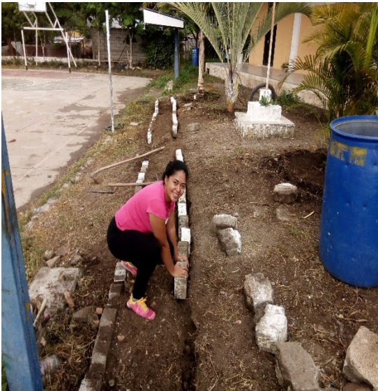
Figura 9. Epesista colocando adoquín para el área verde. Tomado de: Morales, J. (2018).
