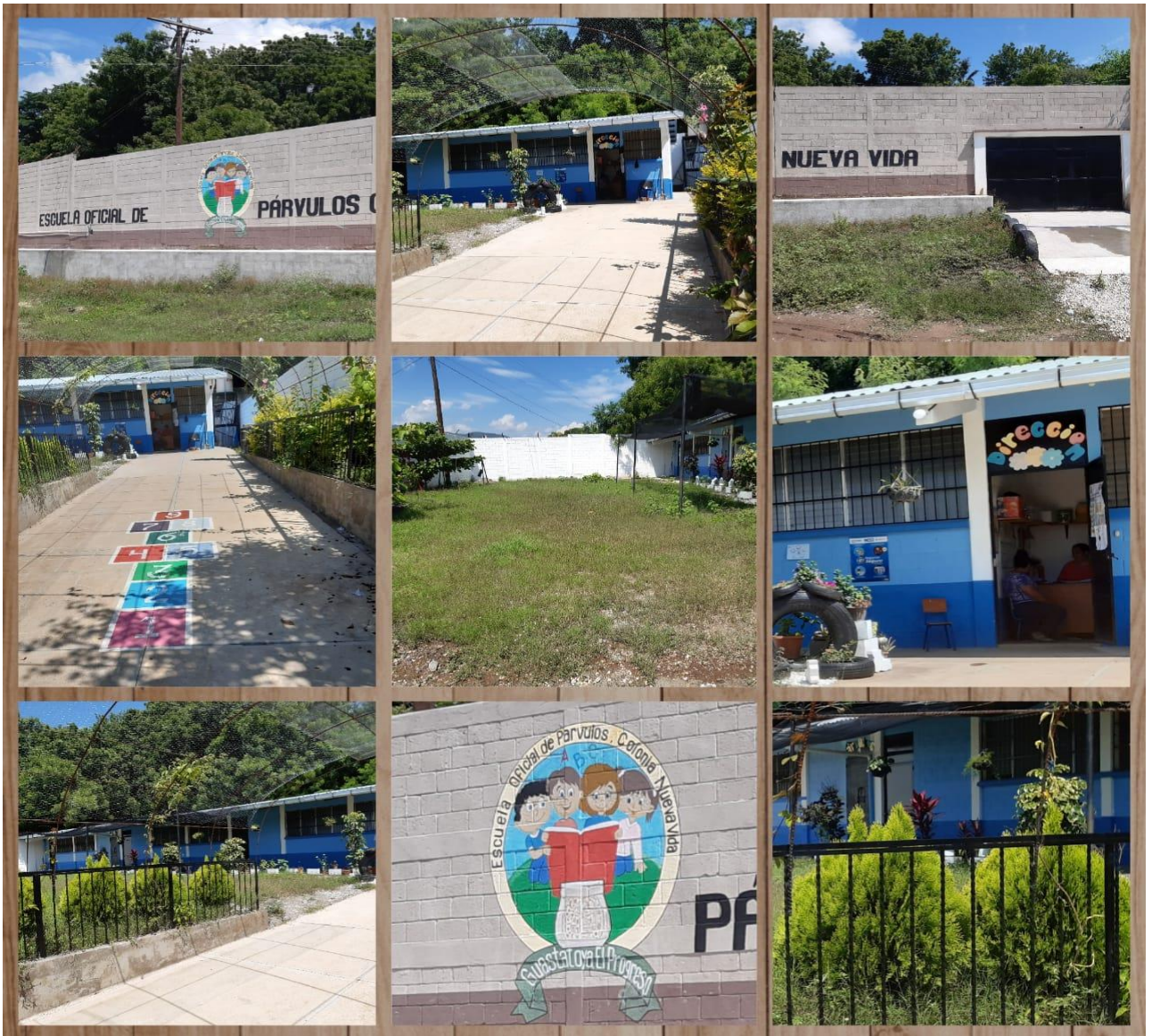
Figura 31 Imágenes donde se realizó el proyecto del comedor escolar para los niños de pre primaria de la Escuela Oficial de Párvulos anexa a Escuela Oficial Urbana Mixta, colonia Nueva Vida, municipio de Guastatoya, departamento de El Progreso.
