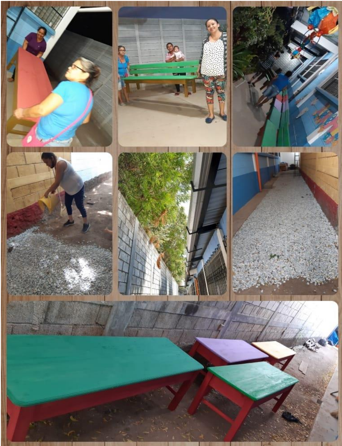
Figura 29 Inicio de trabajo para habilitar el comedor escolar en la Escuela Oficial de Párvulos anexa a Escuela Oficial Urbana Mixta, colonia Nueva Vida, municipio de Guastatoya, departamento de El Progreso.
