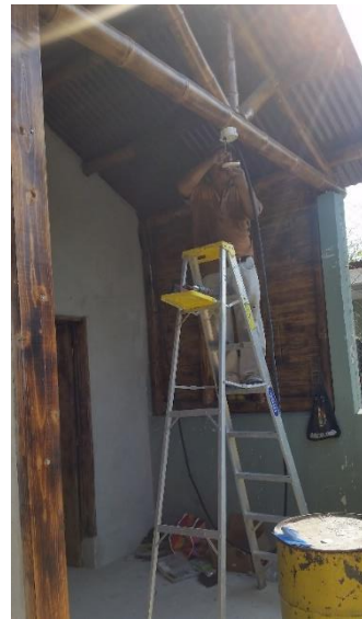
Figura 23. Electricista de la comunidad de Las Morales, municipio de Guastatoya, departamento de El Progreso, colaborando con la instalación eléctrica en biblioteca escolar. Tomado de: Vides, C. (2019).
