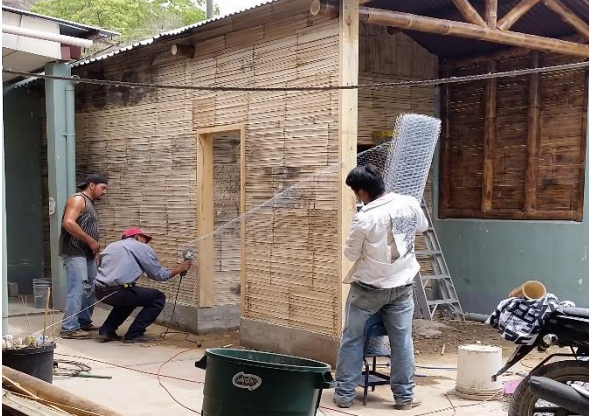
Figura 20. Técnicos en construcción y albañil colocando malla galvanizada en pared lateral de bambú. Tomado de: Vides, C. (2019).
