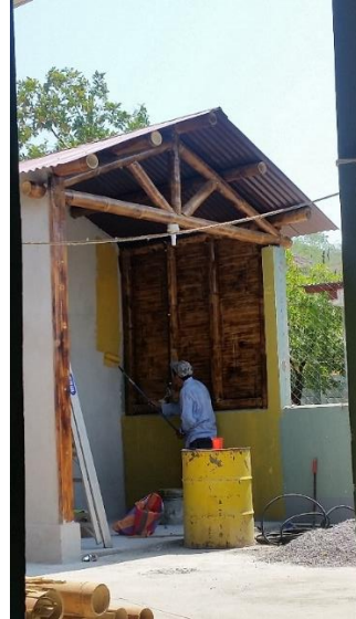
Figura 25. Técnico constructor del VIDER/MAGA, pintando el exterior de biblioteca escolar. Tomado de: Vides, C. (2019).
