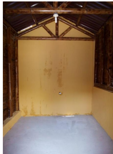
Figura 27. Interior de biblioteca escolar terminada en un 95%. Tomado de: Vides, C. (2019).
