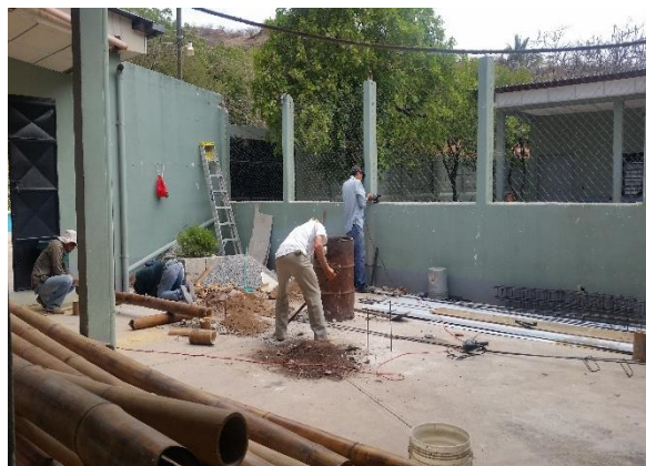
Figura 18. Técnicos en construcción y personas voluntarias de la comunidad iniciando con cimientos de construcción. Tomado de: Vides, C. (2019).
