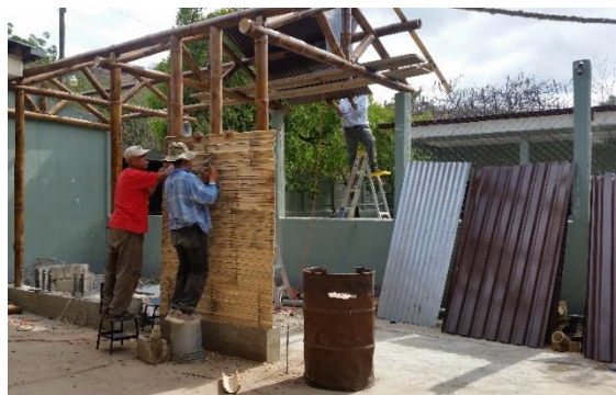
Figura 19. Técnicos en construcción y voluntarios iniciando techado y paredes laterales. Tomado de: Vides, C. (2019).
