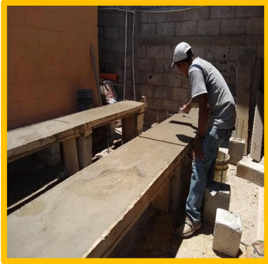
Figura 13. Construcción de mesitas de concreto. (2018)
