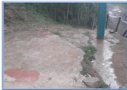
Figura 44. Estado del espacio cuando llueve en la Escuela Oficial Rural Mixta J.M. caserío Plan del Barro. Elaboración Propia (2019).
