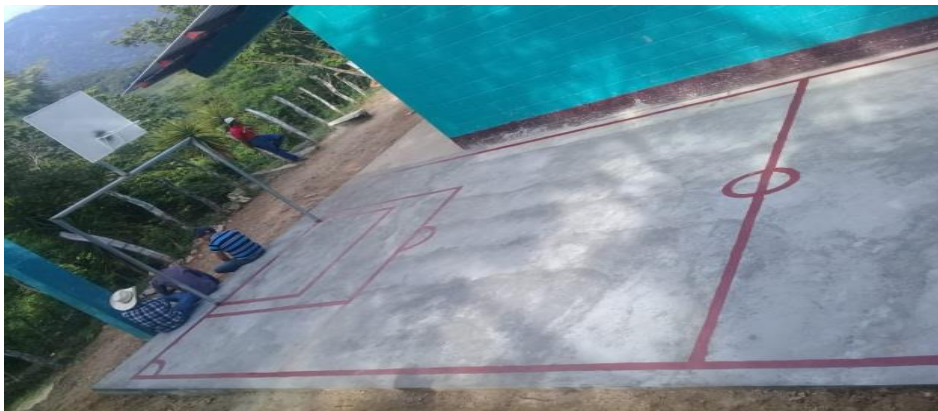
Figura 42. Proyecto terminado. Elaboración propia (2019).
