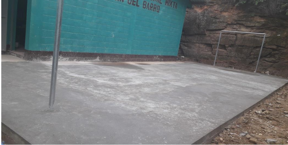
Figura 40. Torta de cemento terminada. (2019).
