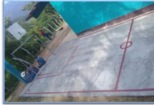
Figura 50. Ejecución terminada del área recreativa en la Escuela Oficial Rural Mixta J.M. caserío Plan del Barro. Elaboración Propia (2019).
