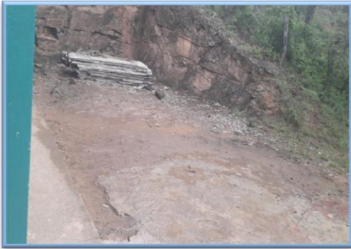
Figura 43. Estado del espacio de la Escuela Oficial Rural Mixta J.M. caserío Plan del Barro. Elaboración Propia (2019).
