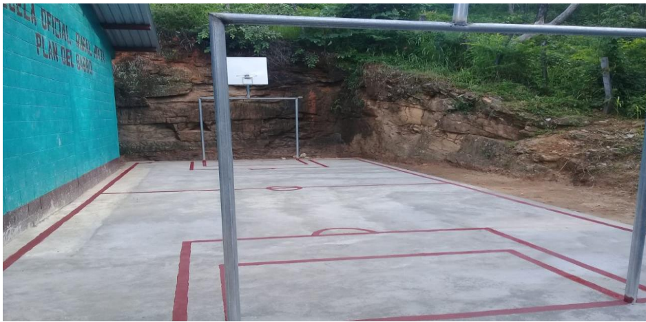
Figura 41. Terminación del proyecto. Elaboración propia (2019).
