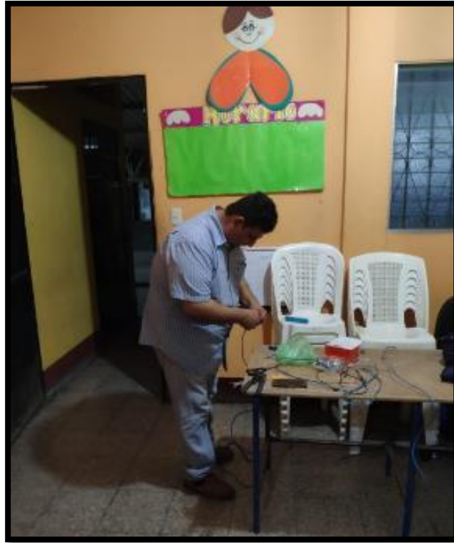
Figura 19. Instalación de red computacional.
