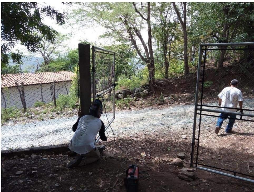
*Figura 51.* Colocación de la puerta en la entrada vehicular del establecimiento. Elaboración propia.
