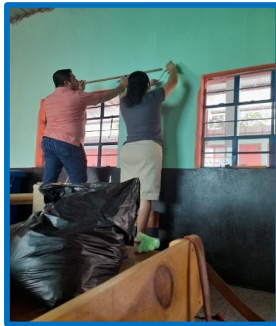
Figura 16. Colocación de cortinas y cortineros. Elaboración propia (2022).
