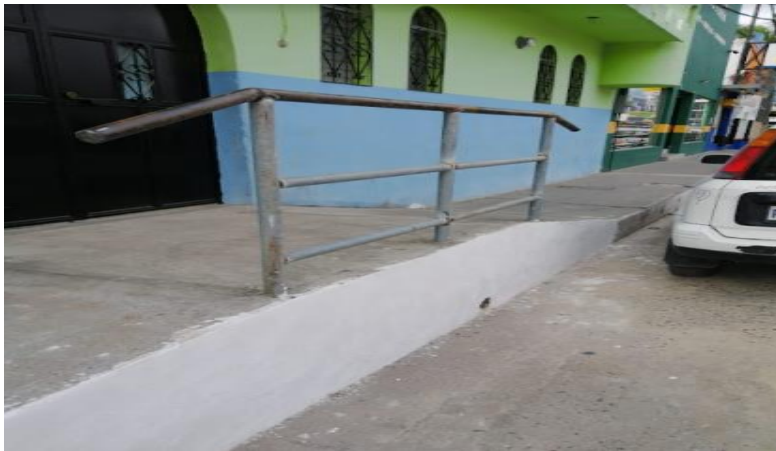
Figura 18. Rampa de accesibilidad externa finalizada. Elaboración propia.
