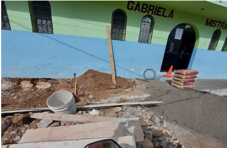
Figura 17. Inicio de construcción de rampa de accesibilidad externa. Elaboración propia.
