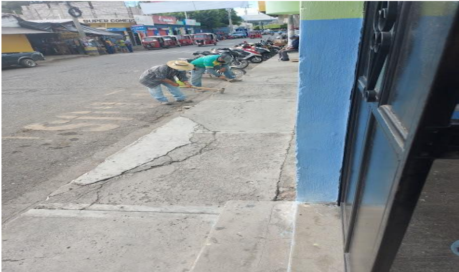
Figura 16. Demolición de acera de ingreso al establecimiento.
