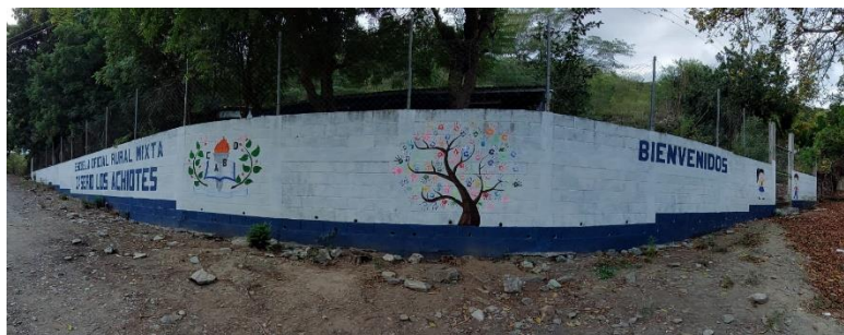
Figura 63. Muro frontal del establecimiento después de la realización del proyecto. Elaboración propia.
