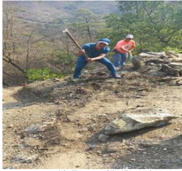
Figura 13. Excavación de zanjas. Elaboración propia.
