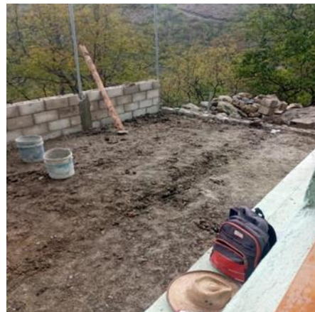
Figura 15. Preparación para la fundición de torta de cemento. Elaboración propia.
