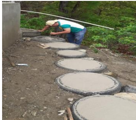
Figura 18. Relleno de cemento en las gradas. Elaboración propia.
