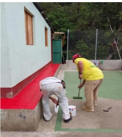
Figura 19. Pintado de cancha. Elaboración propia.
