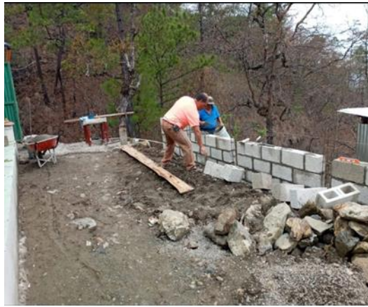
Figura 14. Pegado de block. Elaboración propia.
