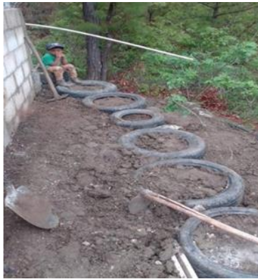
Figura 17. Preparación de gradas. Elaboración propia.
