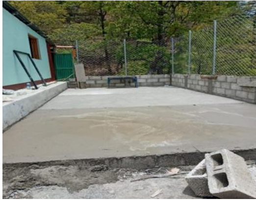
Figura 16. Fundición de torta de cemento. Elaboración propia.
