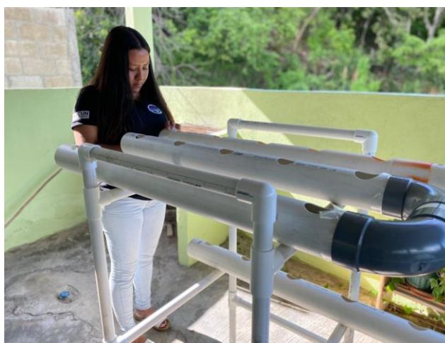
Figura 44. Instalación de los conductos de abastecimiento de agua en la mesa hidropónica. Elaboración propia (2020).
