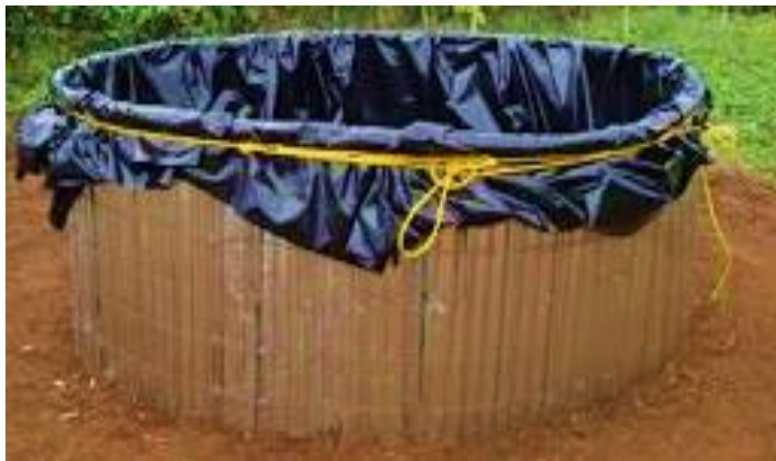
Figura 43. Tanque australiano captador de agua de lluvia. blogsport (2011).
