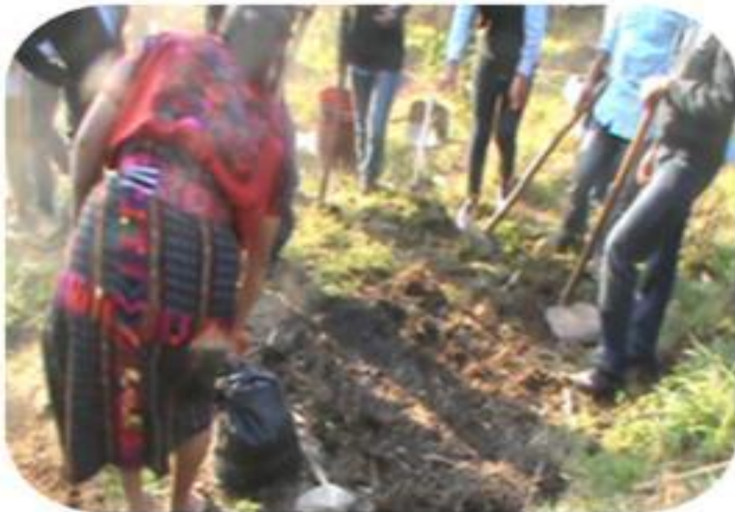
Foto 4. [Fotografía de Elisa Morales]. (Cantón Chulumal Tercero 15 de mayo) Limpieza de terreno para la construcción de abonera
