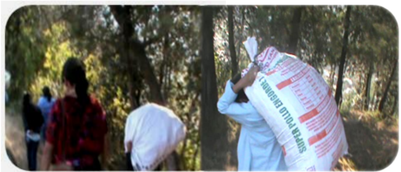
Foto 3. [Fotografía de Diego Ventura]. (Cantón Chulumal Tercero 08 de mayo) Traslado de materia prima para la construcción de aboneras.
