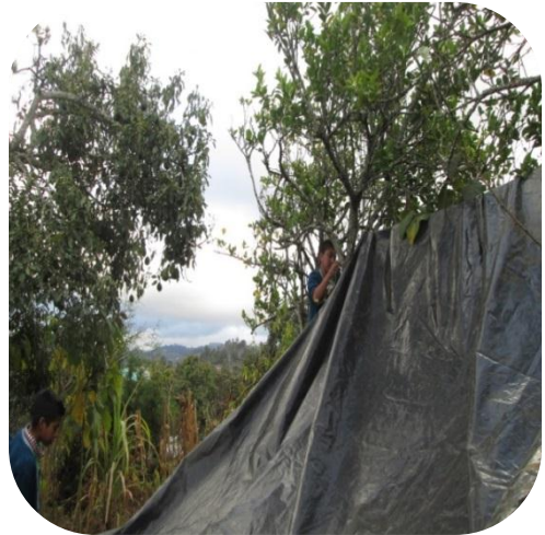
Figura 39. Colocando el techo. Fuente: Tol, M. (04-03-2015)
