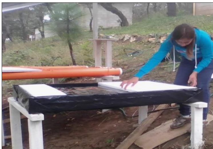
Figura 61. Colocación de las planchas de unicel sobre la caja del sistema de Raíz Flotante.
