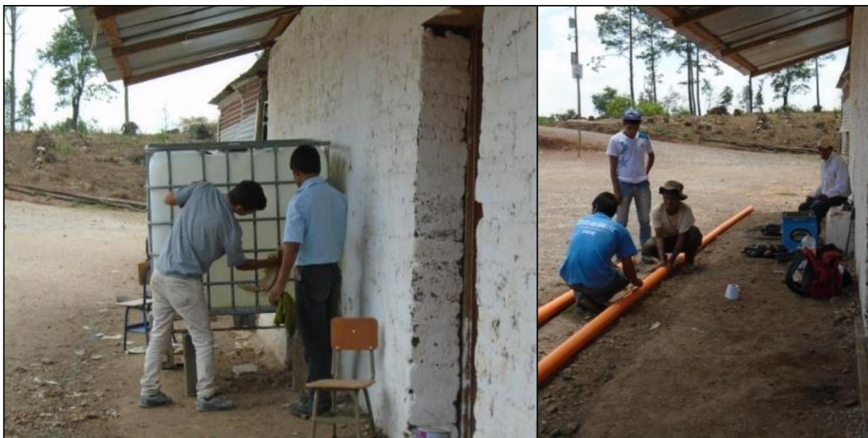
Figuras 38. Recipiente de 1000 litros en proceso de pintado y la instalación de la tubería de conducción
