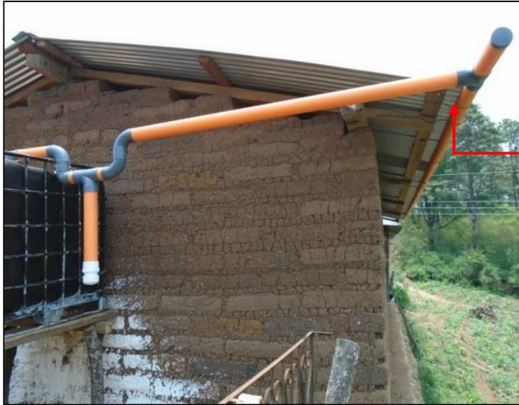
Tal como se observa en la imagen, el tubo para bajada de agua se ha cortado a lo largo y se ha introducido en el filo de la orilla de las láminas.
