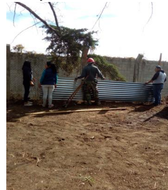
Figura No. 6 Colocación y circulación de laminas
