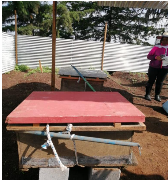
Figura No. 41 Cierre de cajas
