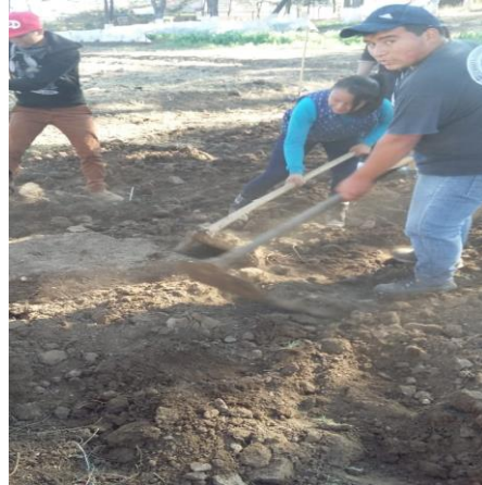
Figura No. 3 Limpieza del terreno
