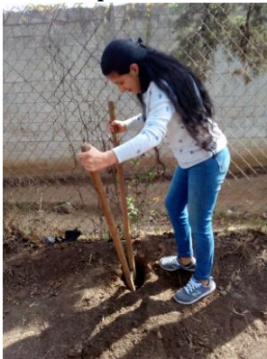
Figura No. 4 Cimiento para la colocación de las reglas
