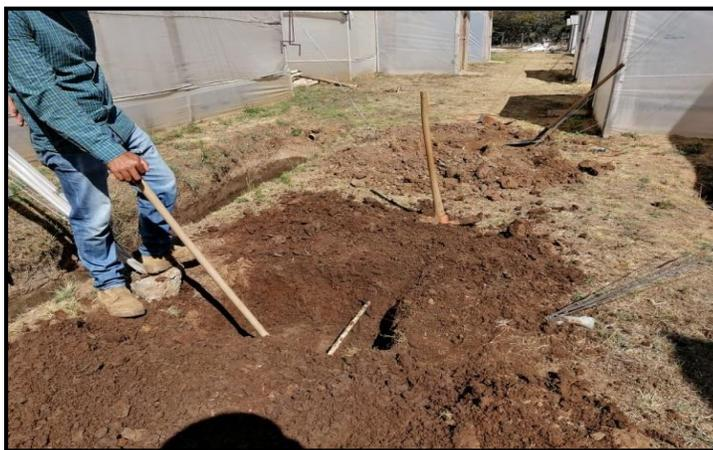
**Figura 41.** Asegurando bases de tensores de invernaderos.
