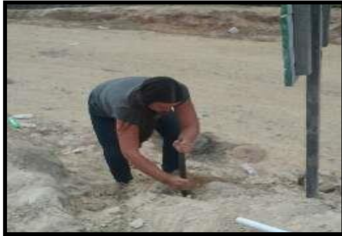
Figura 56. Agujereado para la colocación de rotulo.
