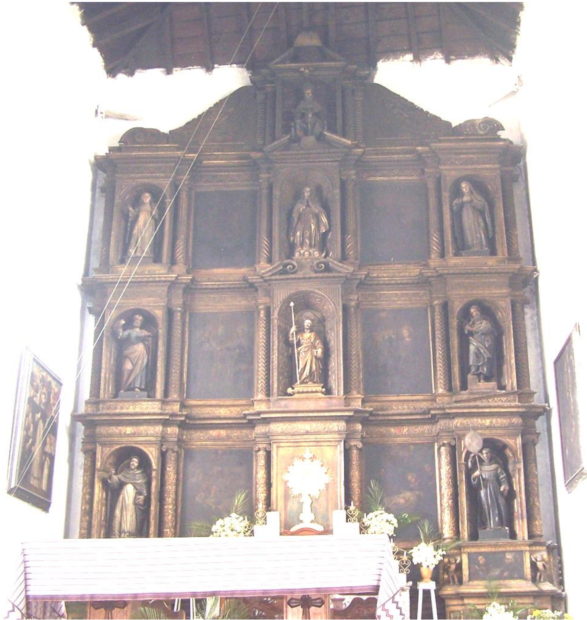
Estructura del retablo mayor de la iglesia de Chichicastenango, de tres cuerpos, cinco calles, una basa y un remate.
