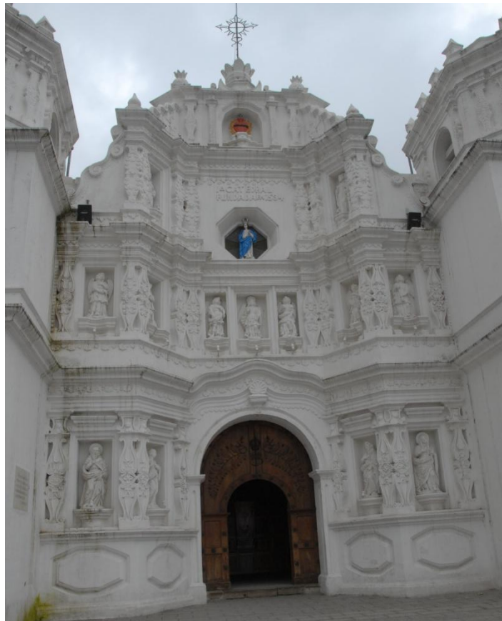
Fachada de la iglesia de Ciudad Vieja.
