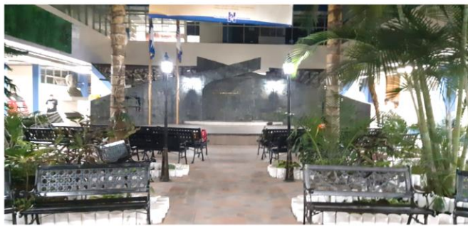
Finalización de la colocación de faroles con pedestales y reflectores
