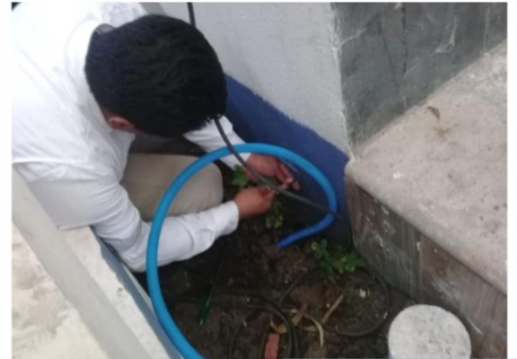
Ingeniero instalando los alambres de conexión eléctrica
